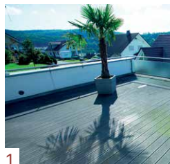
1. Terasa v pôvodnom stave
