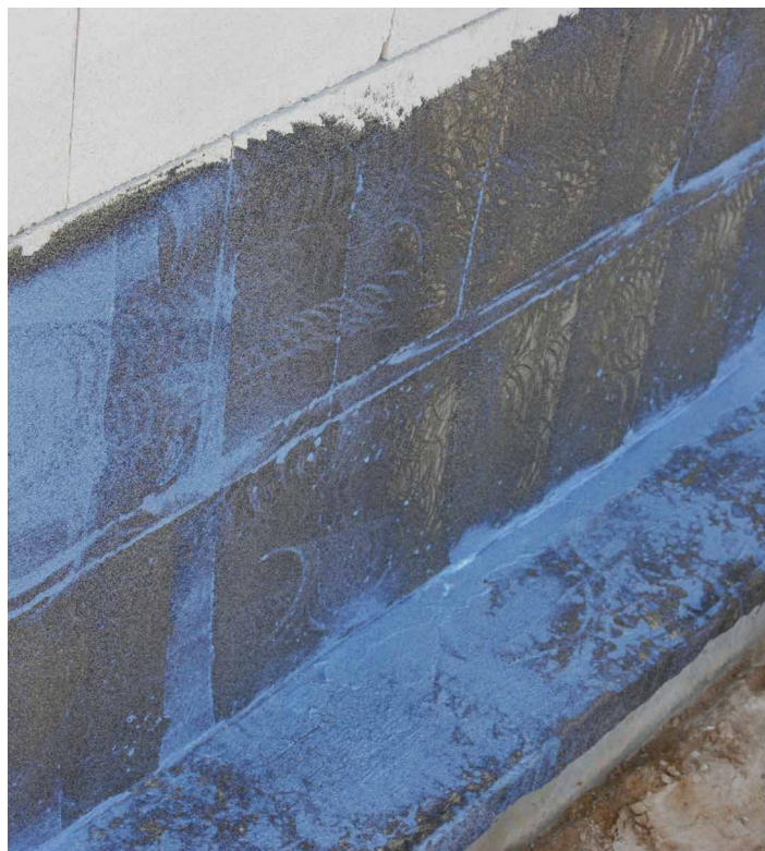
Zmena farby vyrovnávacej stierky/záškrabu pomocou MB 1K rapid
