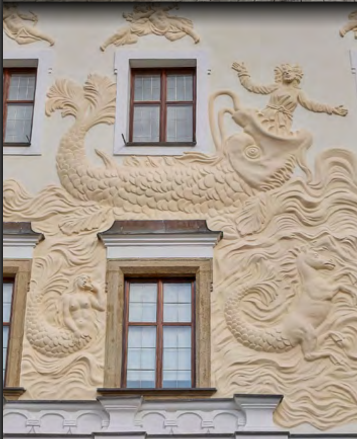
Stavba: Dům U Jonáše, Pardubice
