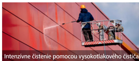
Hrubé čistenie pomocou prúdu vody
