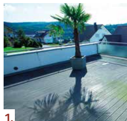
1. Terasa v pôvodnom stave
